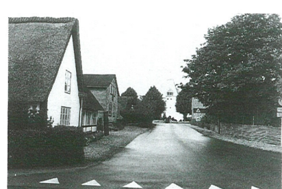
Den gamle indkørsel til Fjelstrup domineres af et par gamle bygninger, og kirketårnet er et markant kendetegn. Ude fra landskabet domineres billedet af en silo i konkurrence med kirketårnet.
